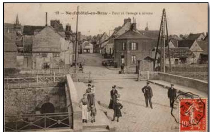
Le passage à niveau où officiait bénévolement le chien Marquis. Sur le pont, deux employés des chemins de fer de l'Ouest dont peut-être le vrai garde-barrière... Les trains ont cessé de circuler en 1988 lors de la fermeture du tronçon Serqueux - Dieppe devenu une piste cyclable, l'Avenue verte.
